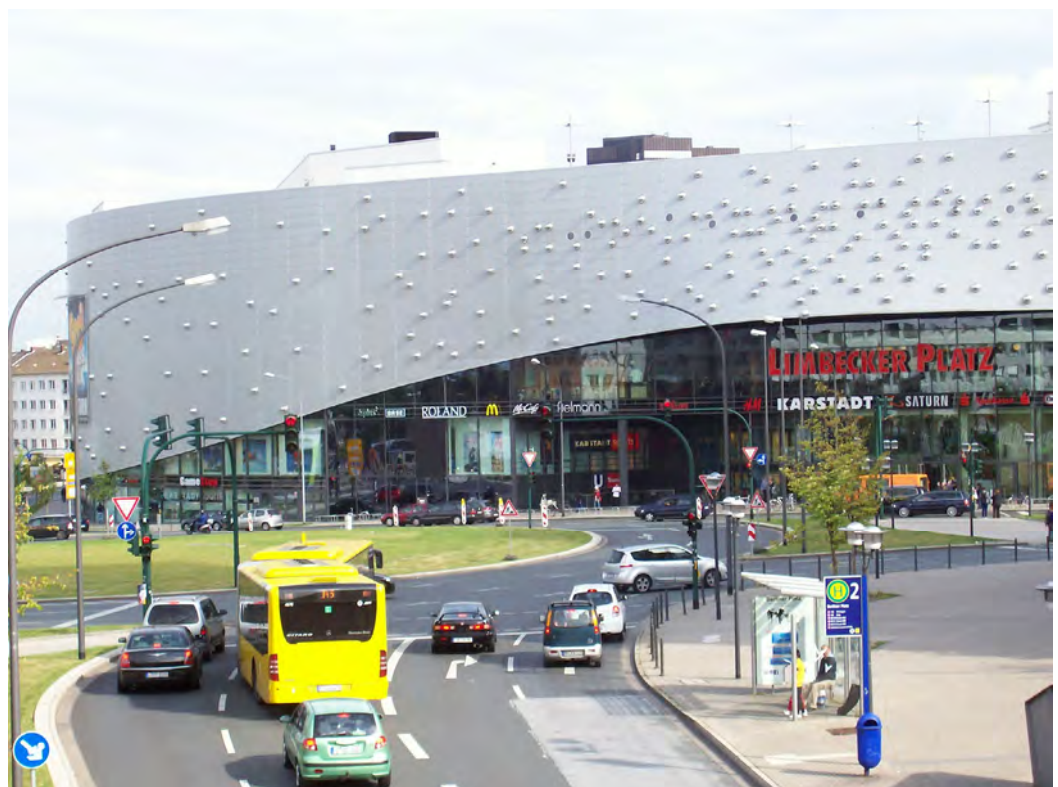
Großflächiges Einzelhandelsprojekt allerdings im Zentralen Versorgungsbereich: Einkaufszentrum Limbecker Platz in der Essener Innenstadt
