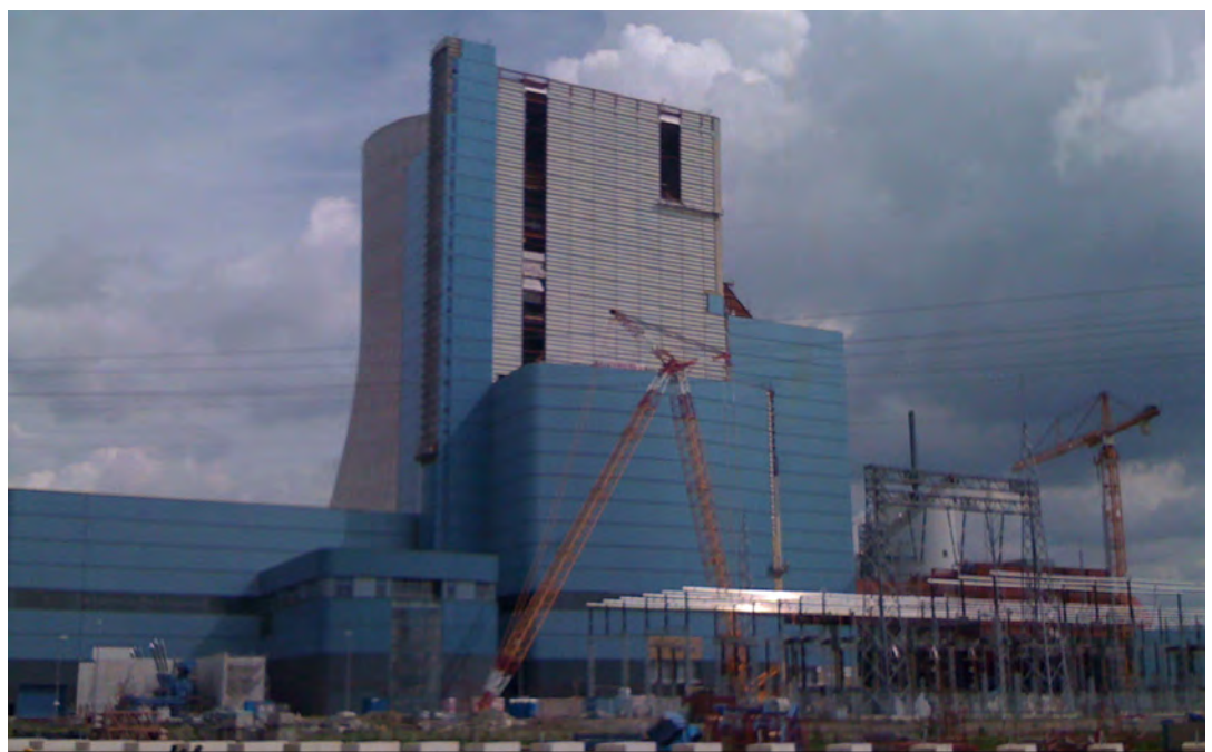
Baustelle des Steinkohlekraftwerks Datteln IV im August 2010
